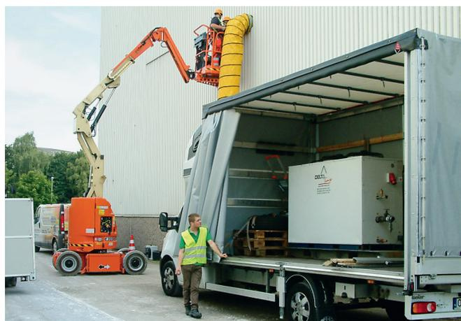
Ein 500 mm Luftschlauch wird am bauseits vorbereiteten Wandanschluss befestigt.
