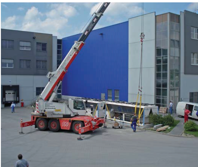
Kranentladung Kaltwassersätze für Speditionunternehmen 2 x 600 kW
