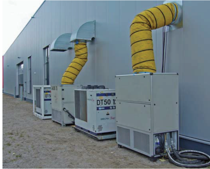
Mobile Hallenklimatechnik für Metallverarbeitungsbetrieb
